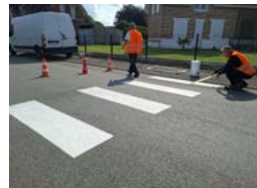
Remise en peinture des passages pour piétons aux abords des bâtiments municipaux et axes principaux.
