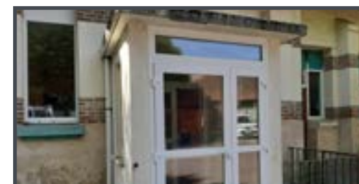
École Curie : changement de la porte et des fenêtres côté cour.
