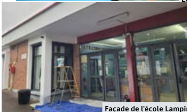
Façade de l'école Lampin.
